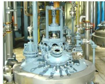
「ユーブラスト」は、爆発防止やケミカルハザード対策を考慮した反応槽などへの粉体の投入装置です。反応槽側の溶媒ガス雰囲気へ、粉体を不活性ガス（ $N_2$ ガス等）と共に、発塵も無く、密閉状態で、安全に投入することができます。
